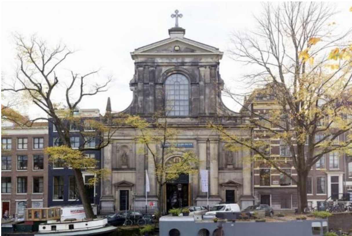
Kerkgebouw De Duif, foto Stadsherstel Amsterdam
